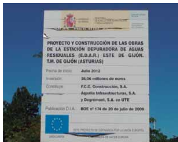
Panel informativo de la obra donde se aprecian los detalles de una obra inacabada y en donde figura expresamente el DIA anulado
