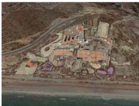
Obras del hotel ilegal del Algarrobico. Tomado de Google Earth ®
