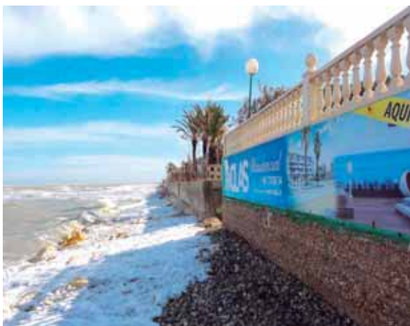
Efecto rebote del oleaje contra la primera línea de costa que provoca una mayor erosión y favorece el retroceso de la costa en un nuevo escenario de cambio climático.
