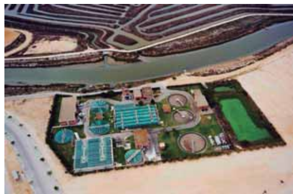
Depuradora El Torno (Chiclana) y río Iro
