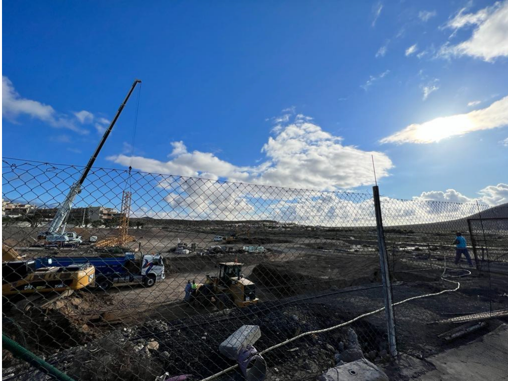
Obras en curso; "Sotavento Suites"
